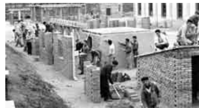
Costruzione opere murarie, 1951.
