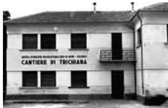
Una vecchia foto del cantiere di Trichiana.
