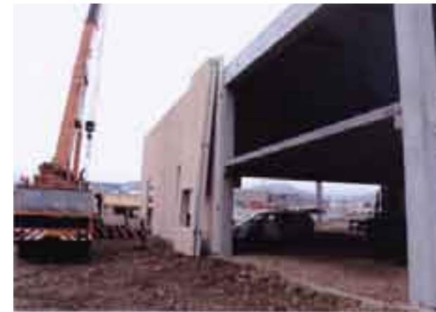
Lavori di costruzione della nuova sede (primo modulo) a Prato Sardo.
