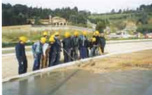
Allievi in un cantiere di opere stradali.
