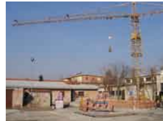
Esterno della Scuola con attrezzature per corso gruisti.
